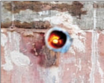
Bild 10: Wasserdampffahne am Gebläseaustritt
